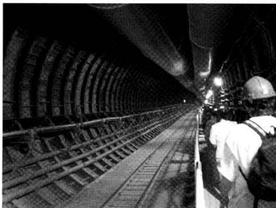
ユッカマウンテン北側入口から坑内へ
